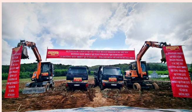
Những khẩu hiệu trên công trường Đường dây 500kV mạch 3 Quảng Trạch – Quỳnh Lưu – Thanh Hóa
