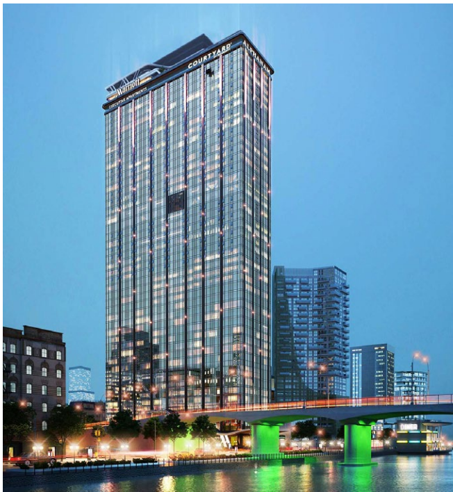
Thang máy FUJIALPHA dùng cho công trình biểu tượng mới của Thành phố Đà Nẵng - Khách sạn Courtyard by Marriott và Marriott Executive Apartments Đà Nẵng với 14 thang, tốc độ 7m/s
